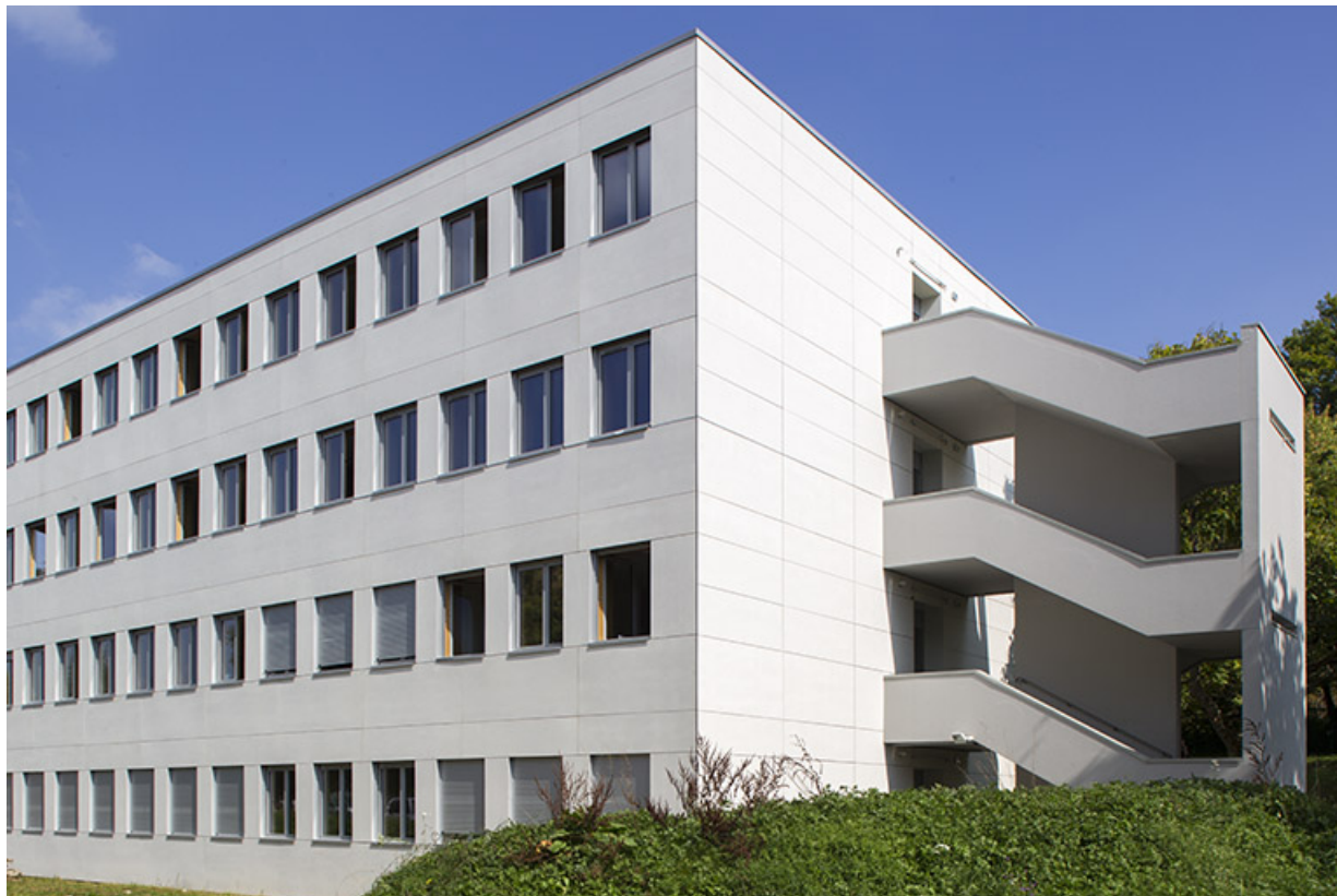
Internat : détail des parements de façade.
