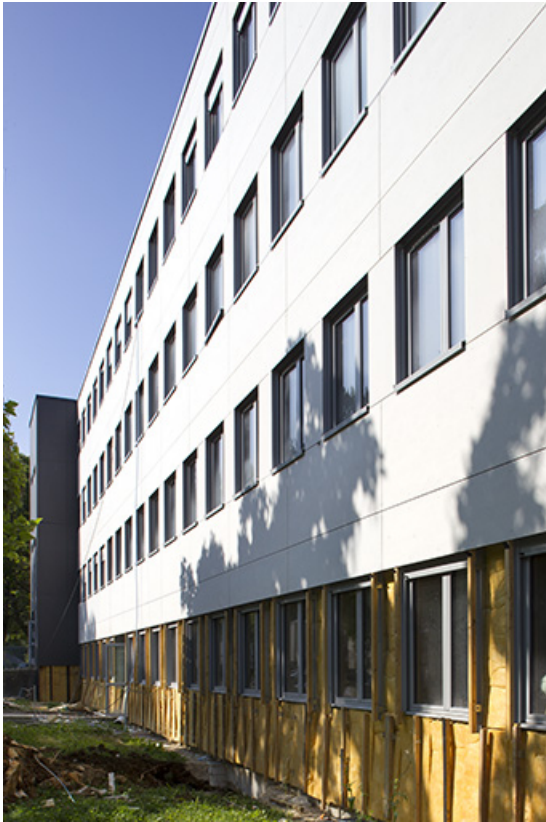
Internat : isolation des façades.
