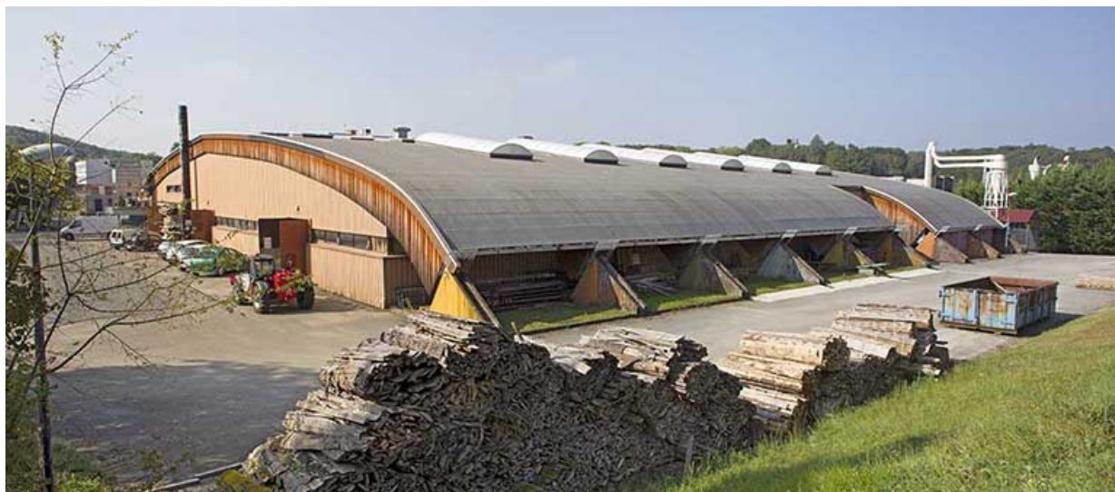
Atelier : couverture avec charpente en lamellé collé.
