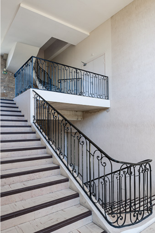
Internat, escalier intérieur.
