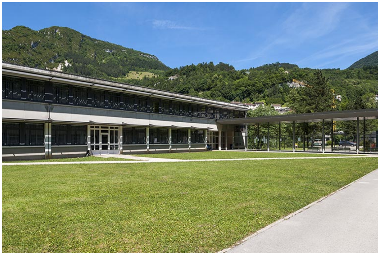
Externat tertiaire : façade antérieure.
