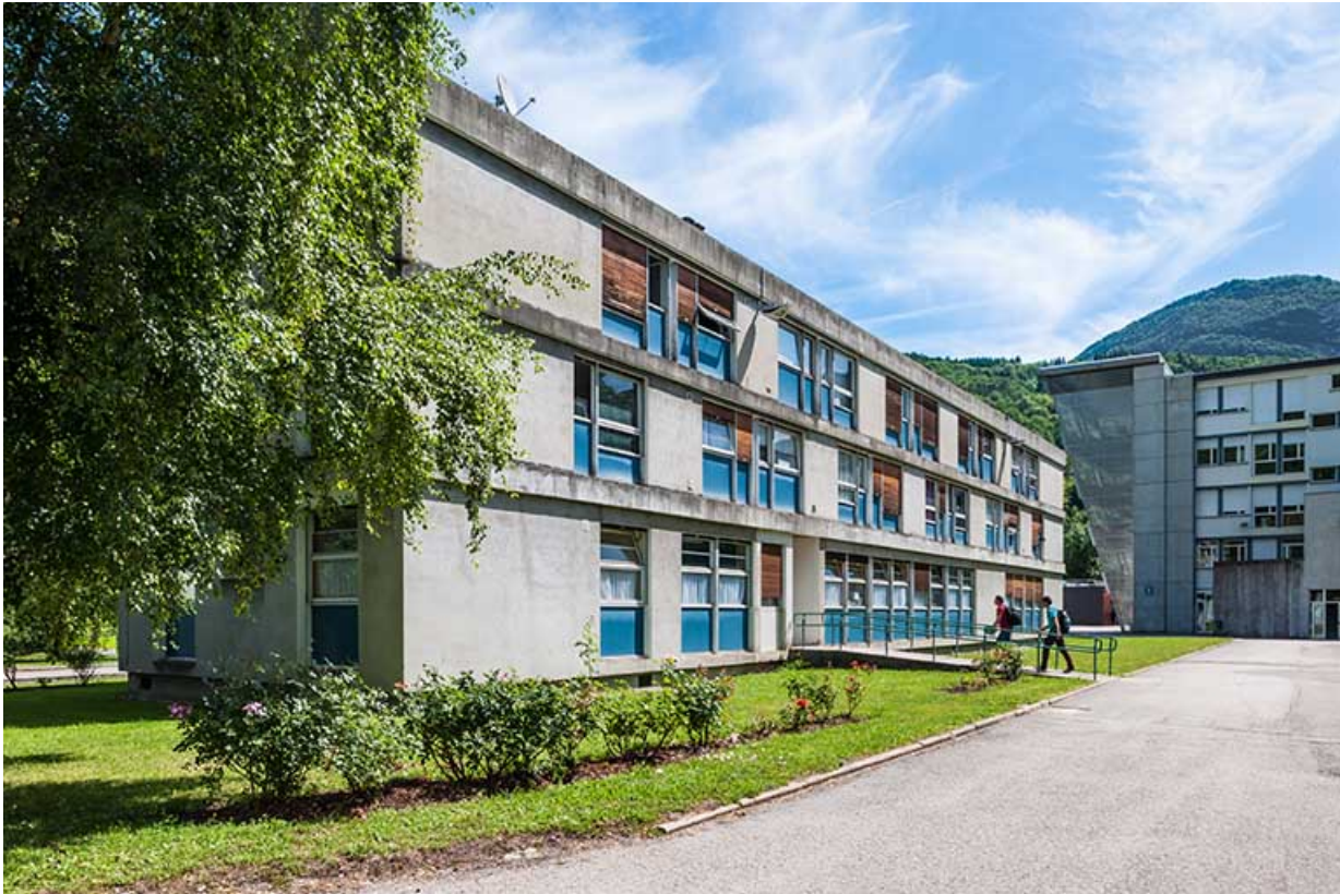
Administration : façade postérieure.
