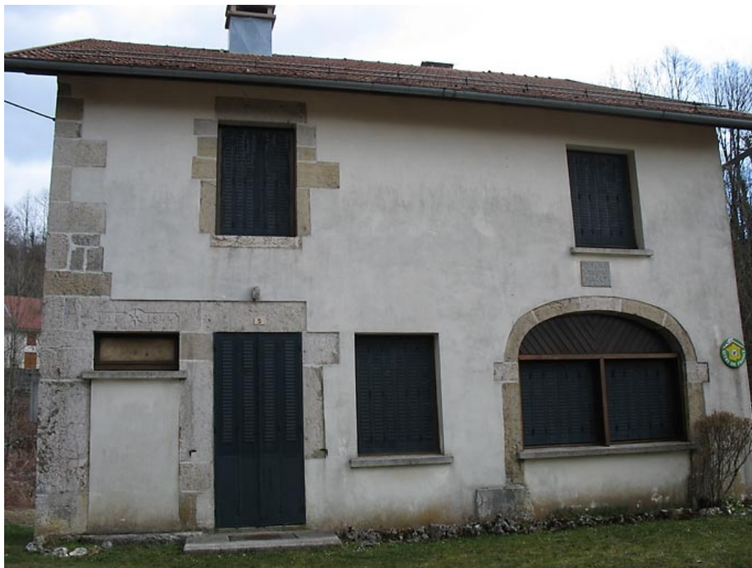
Vue générale sur façade antérieure.
