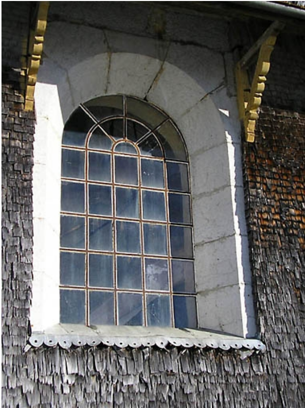
Vue d'une baie.
