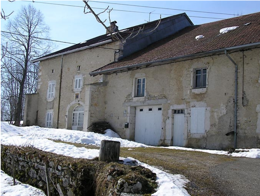
Vue de trois quarts sur l'édifice.
