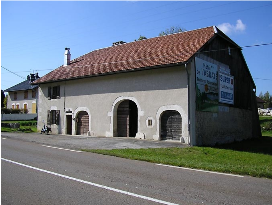
Façade antérieure et pignon vus de trois quarts.
