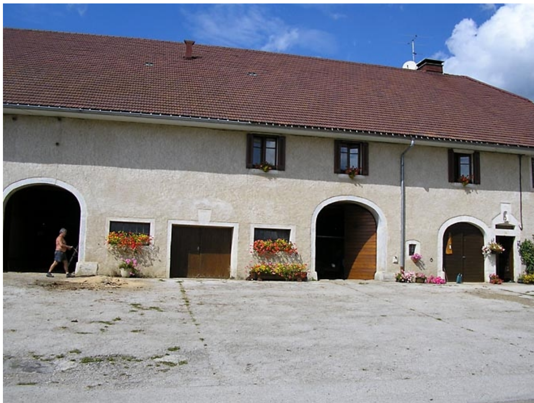
Vue latérale de la façade antérieure.
