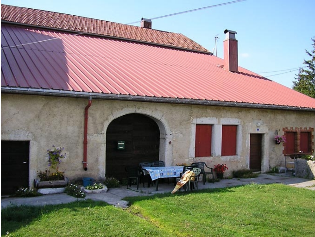
Vue de la façade antérieure.
