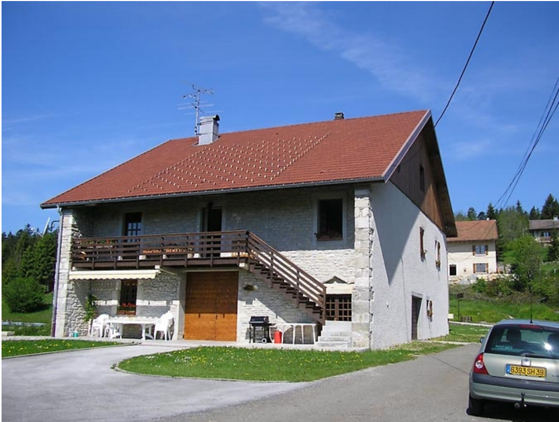
Façade postérieure et pignon sud-ouest.
