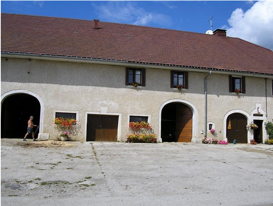
Vue latérale de la façade antérieure.
