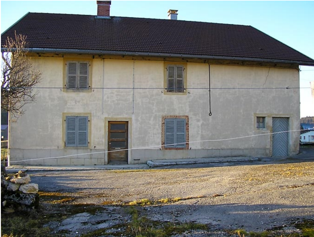
Façade antérieure. 39, Chaux-des-Prés
