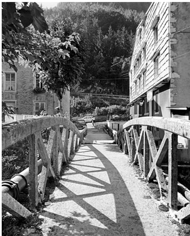
Tablier et garde-corps, depuis la rive droite.
