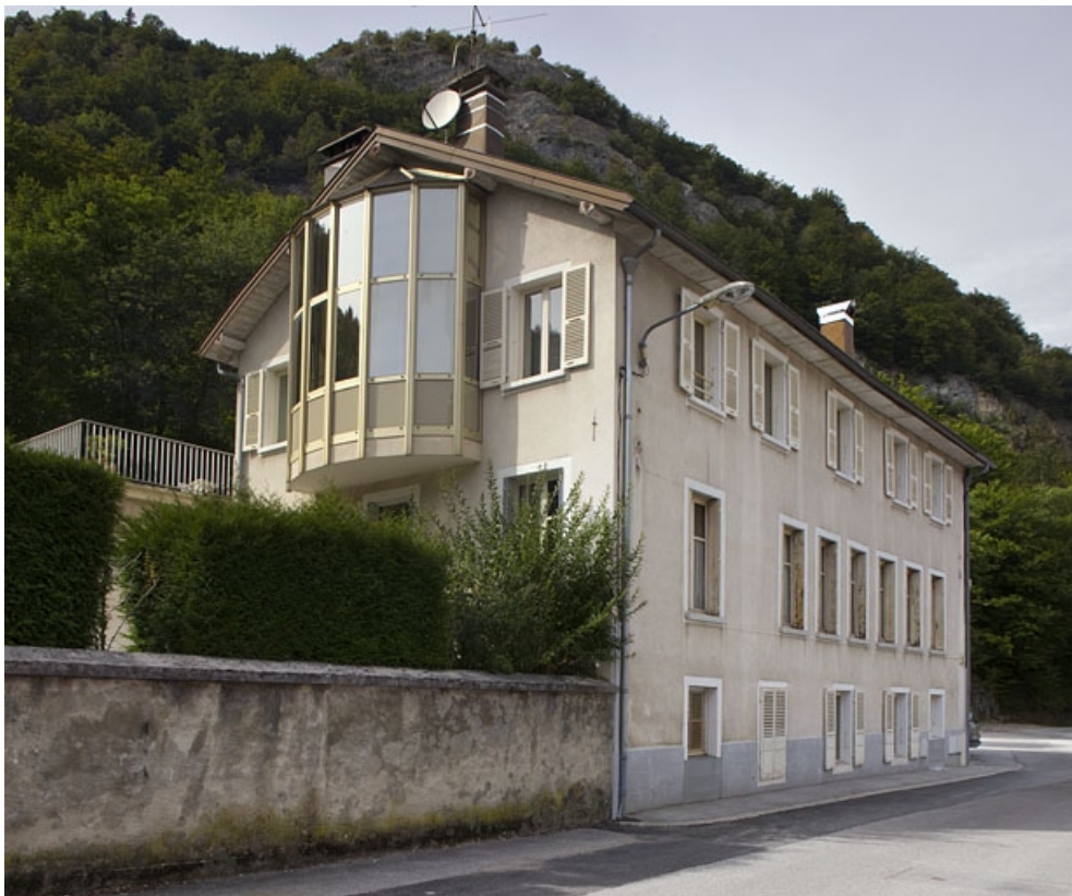
Elévation antérieure, de trois quarts gauche.
