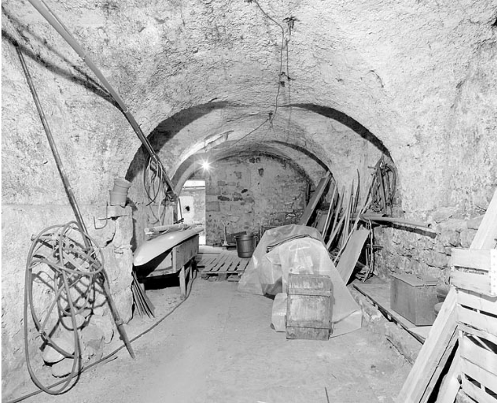
Aile est : rez-de-chaussée voûté.
