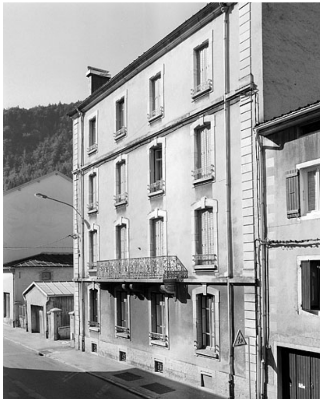
Vue d'ensemble depuis le nord-est : élévation antérieure.
