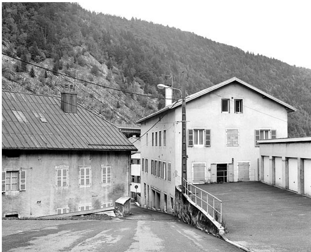
Immeuble : élévation occidentale.
