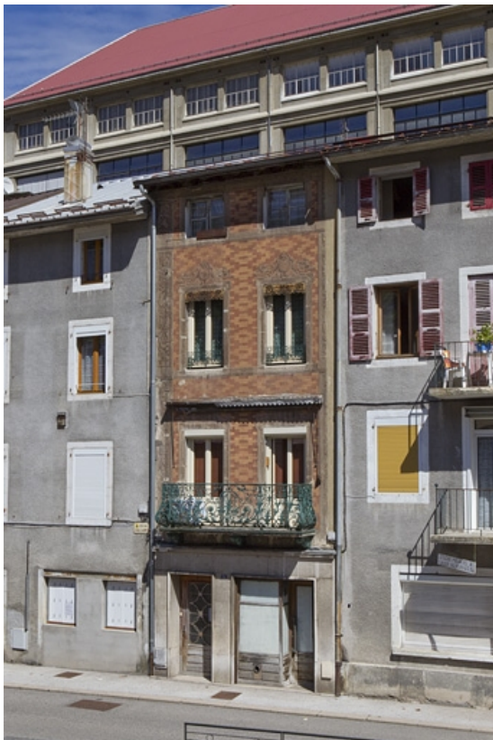
Elévation antérieure, de trois quarts droite.
