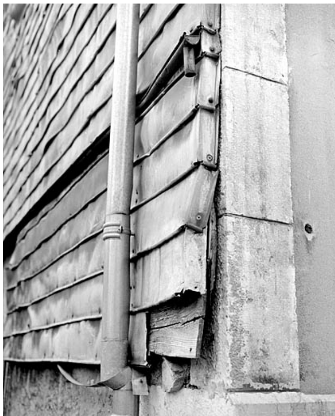
Essentage de tôle sur le mur sud.
