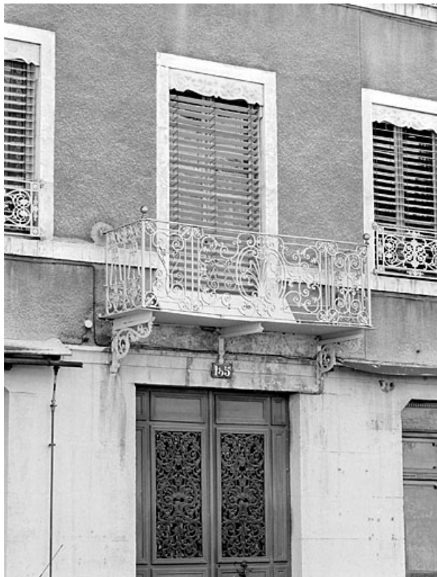
Entrée principale et balcon.
