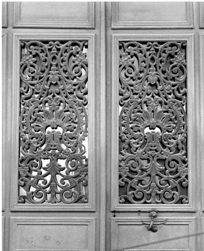
Entrée principale : grille des vantaux.
