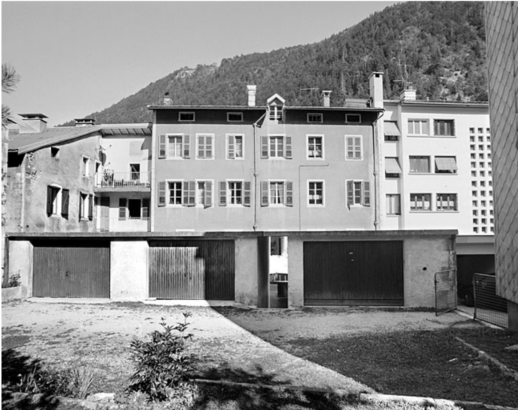
Elévation postérieure et garages.
