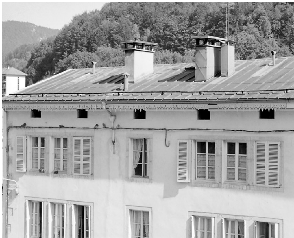
Façade antérieure : fenêtres jumelées aux étages.
