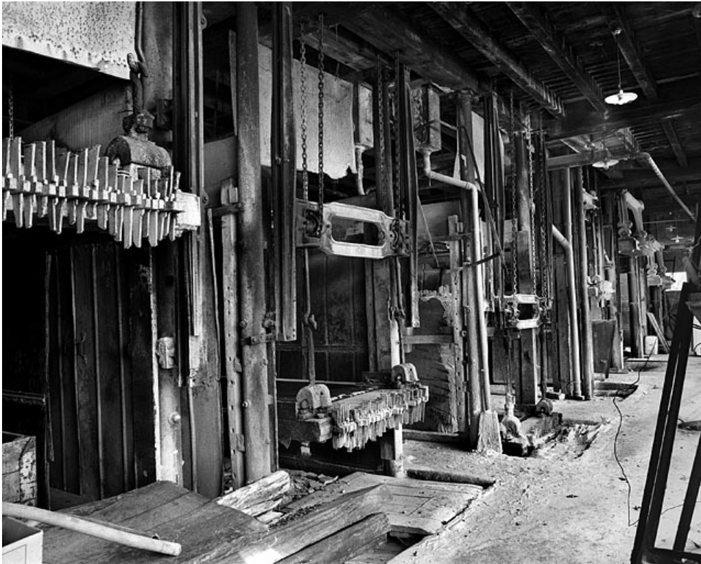
Vue d'ensemble des châssis multilames.
