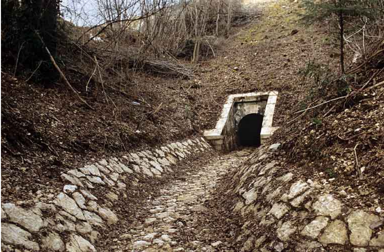
Aqueduc : tête aval et rigole (cadrage horizontal).
