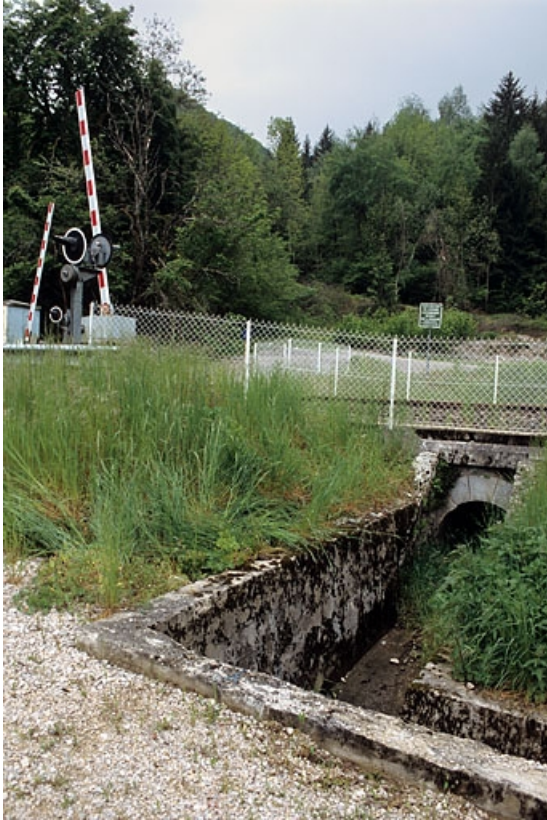
Tête aval (est) de l'aqueduc.
