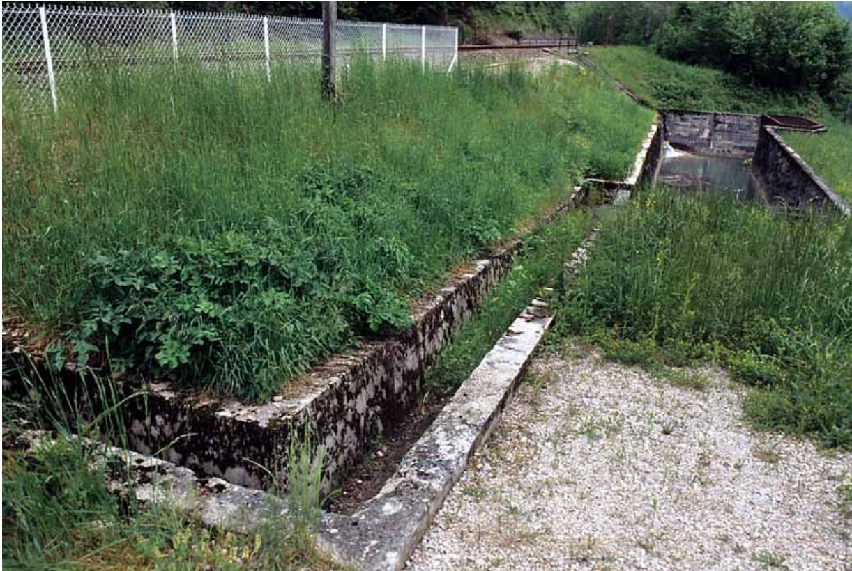
Canal reliant l'aqueduc au réservoir.
