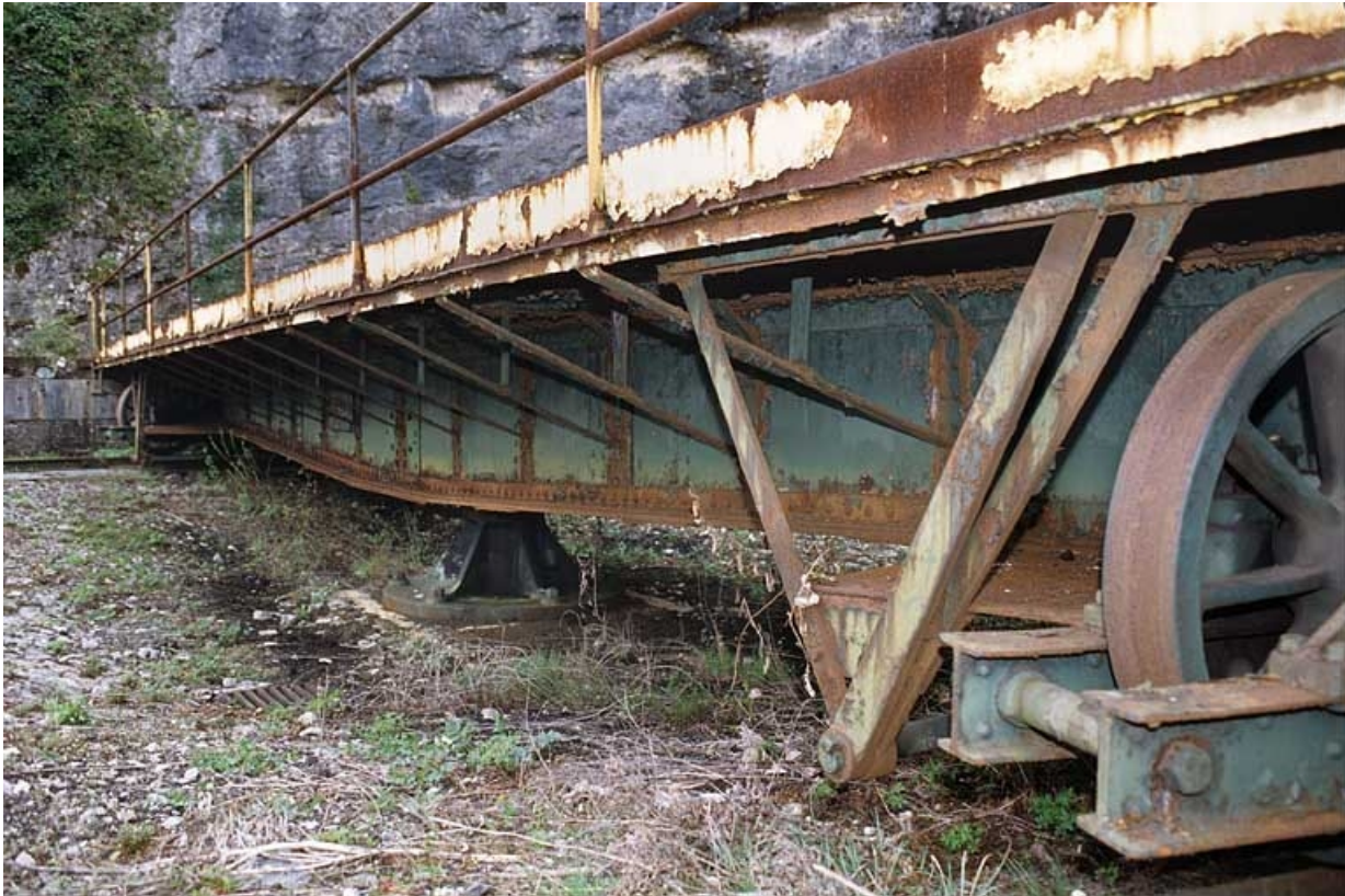
Tablier vu en enfilade.
