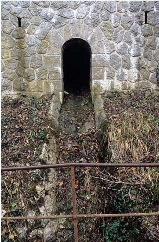
Aqueduc de 70 cm.
