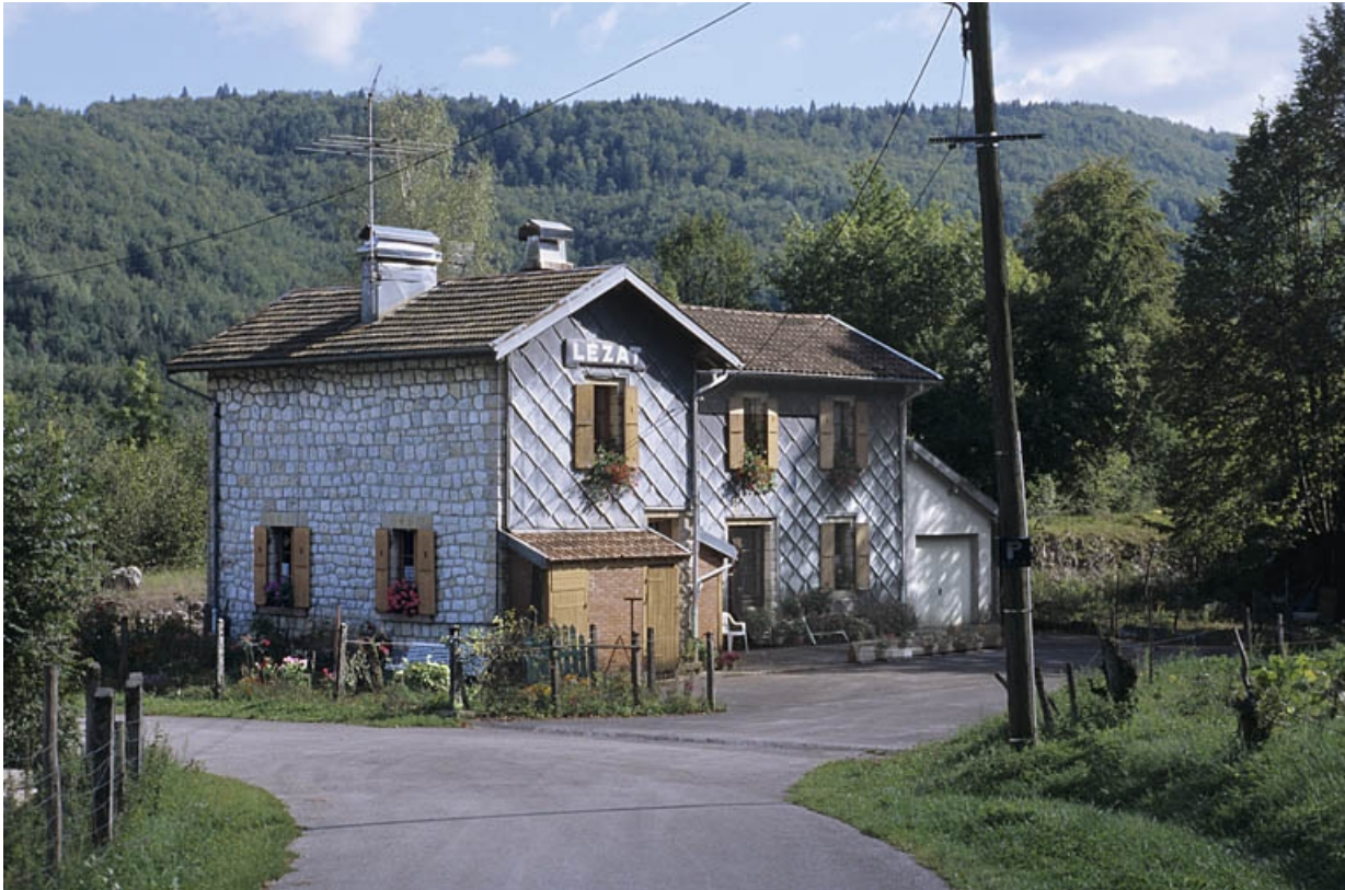
Façades antérieure et latérale gauche.
