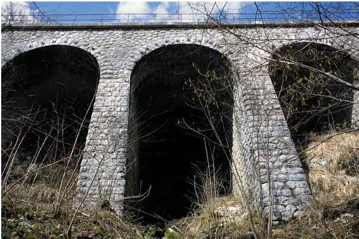
Mur de soutènement de la route : arcades.
