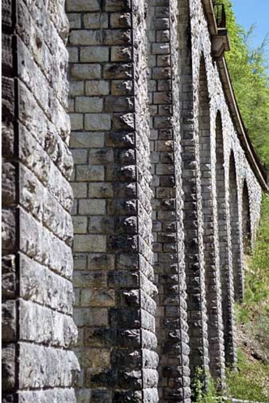
Viaduc du Puits : piles vues en enfilade.
