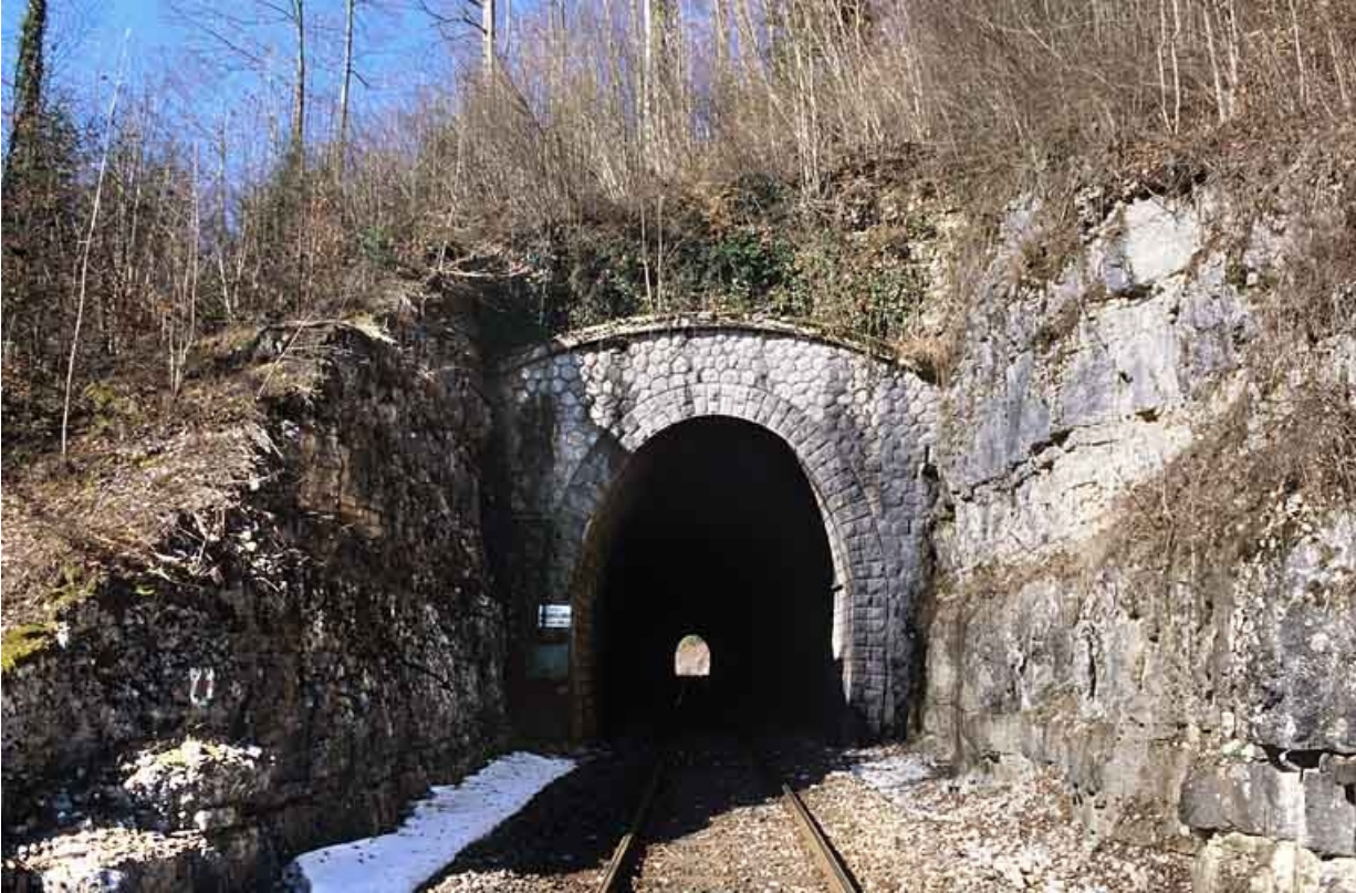
Tunnel des Bataillards : tête côté Andelot-en-Montagne (est).
