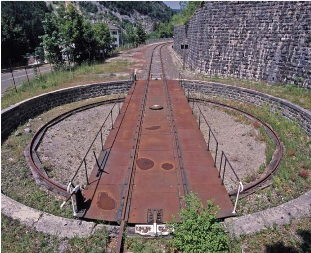
Tablier, fosse et chemin de roulement.
