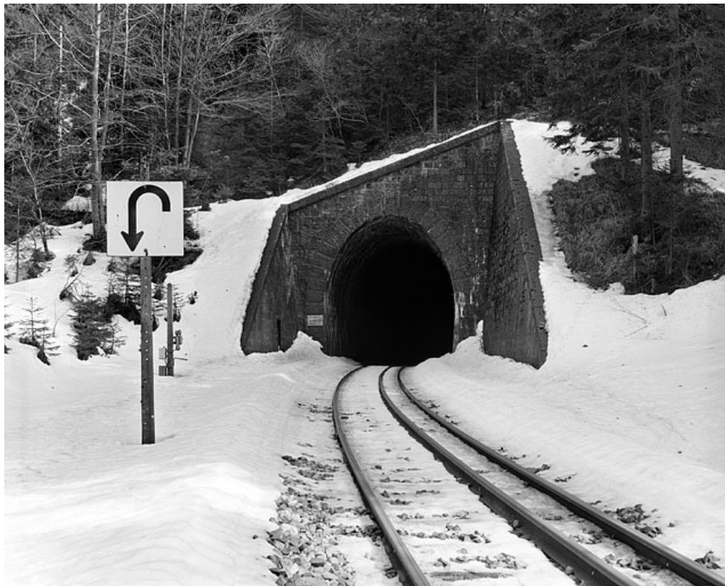
Tête côté La Cluse. Signalant un tunnel à mauvaise ventilation, le panneau autorise le train à " refouler " (faire marche arrière) en cas d'impossibilité de poursuivre en marche avant.
