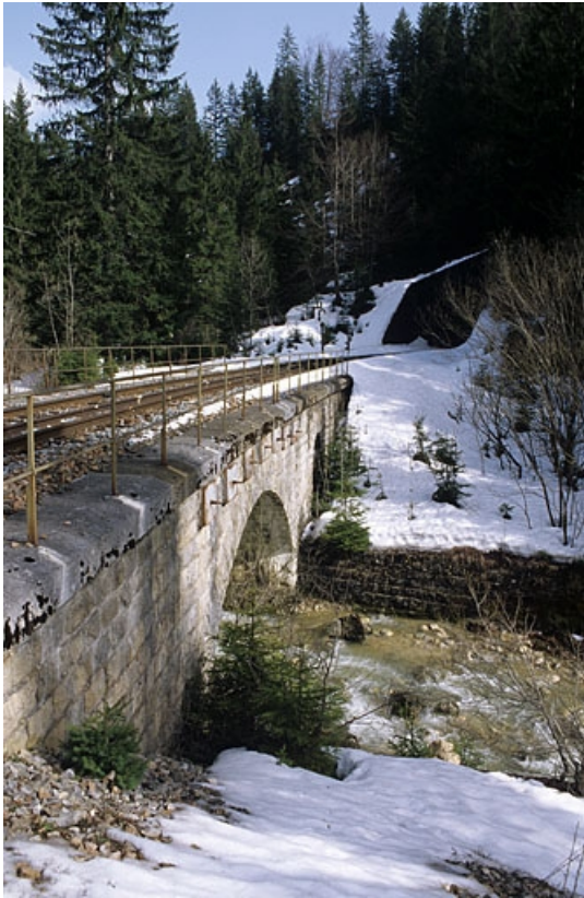
Vue d'ensemble, depuis le sud-ouest (aval).
