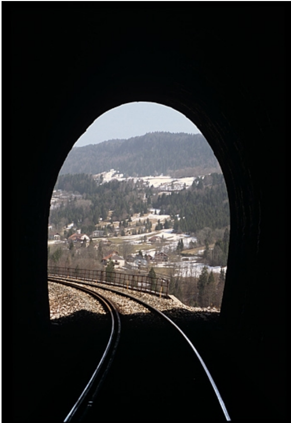
Tête côté La Cluse, depuis l'intérieur.
