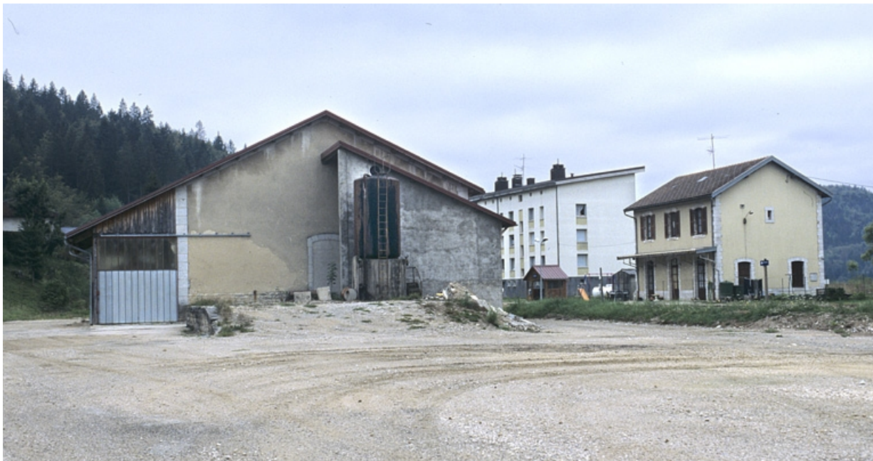
Entrepôt, depuis le nord (côté Andelot-en-Montagne).
