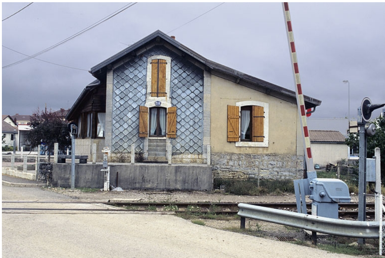
Façade sud (côté voie).
