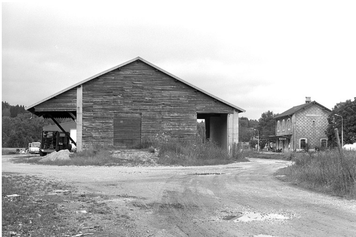
Entrepôt : façade postérieure (sud).
