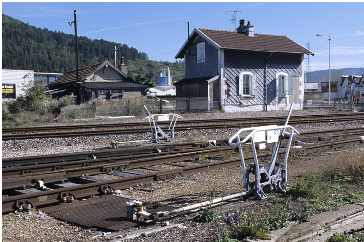
Vue d'ensemble, depuis l'ouest.
