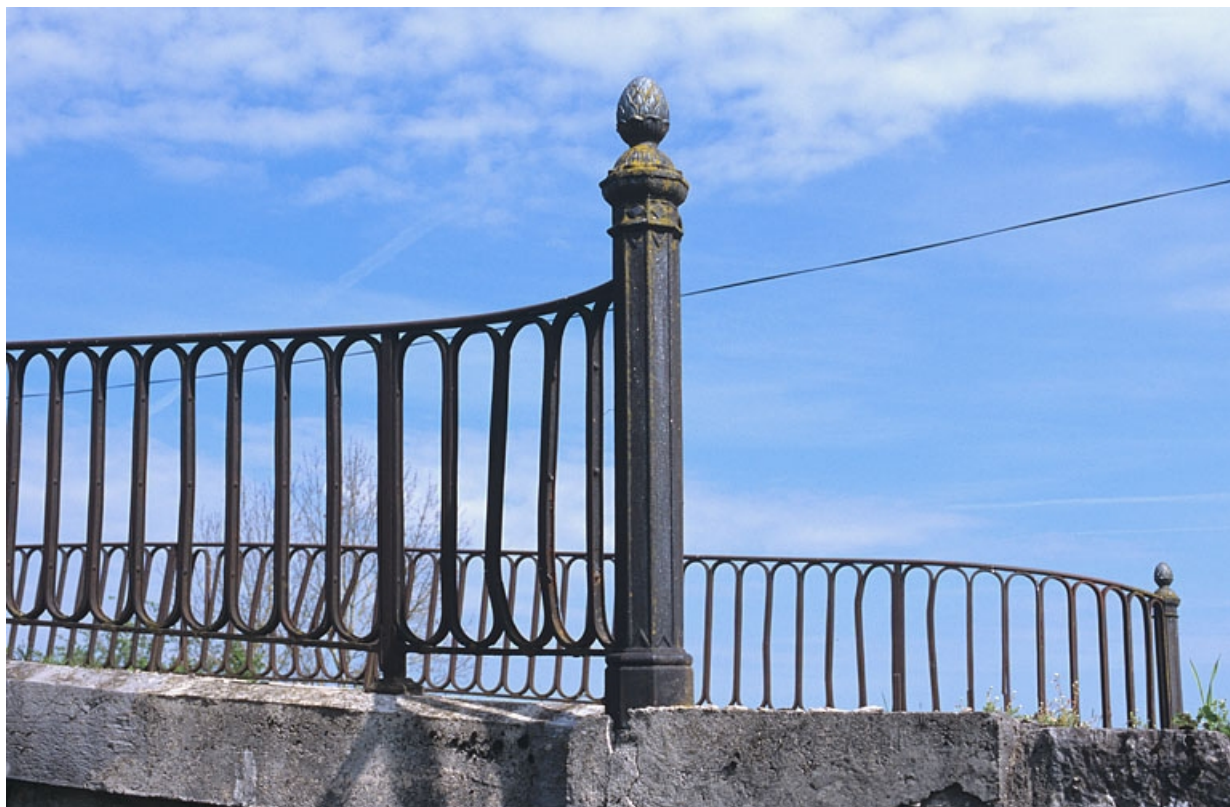
Potelet ouest du garde-corps nord.
