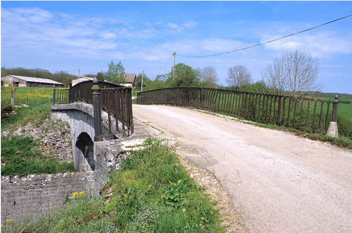
Tablier et garde-corps, depuis le nord-ouest.
