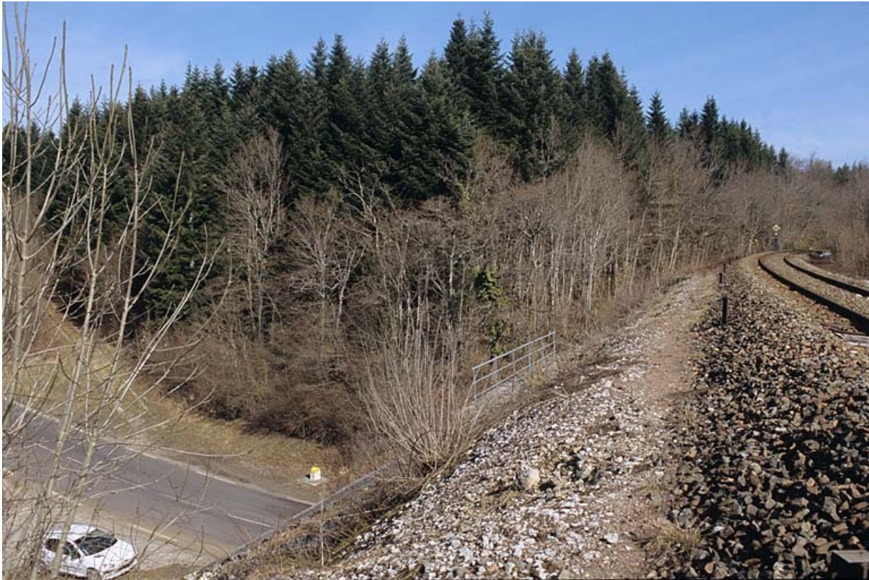
Plate-forme, depuis la voie côté La Cluse.
