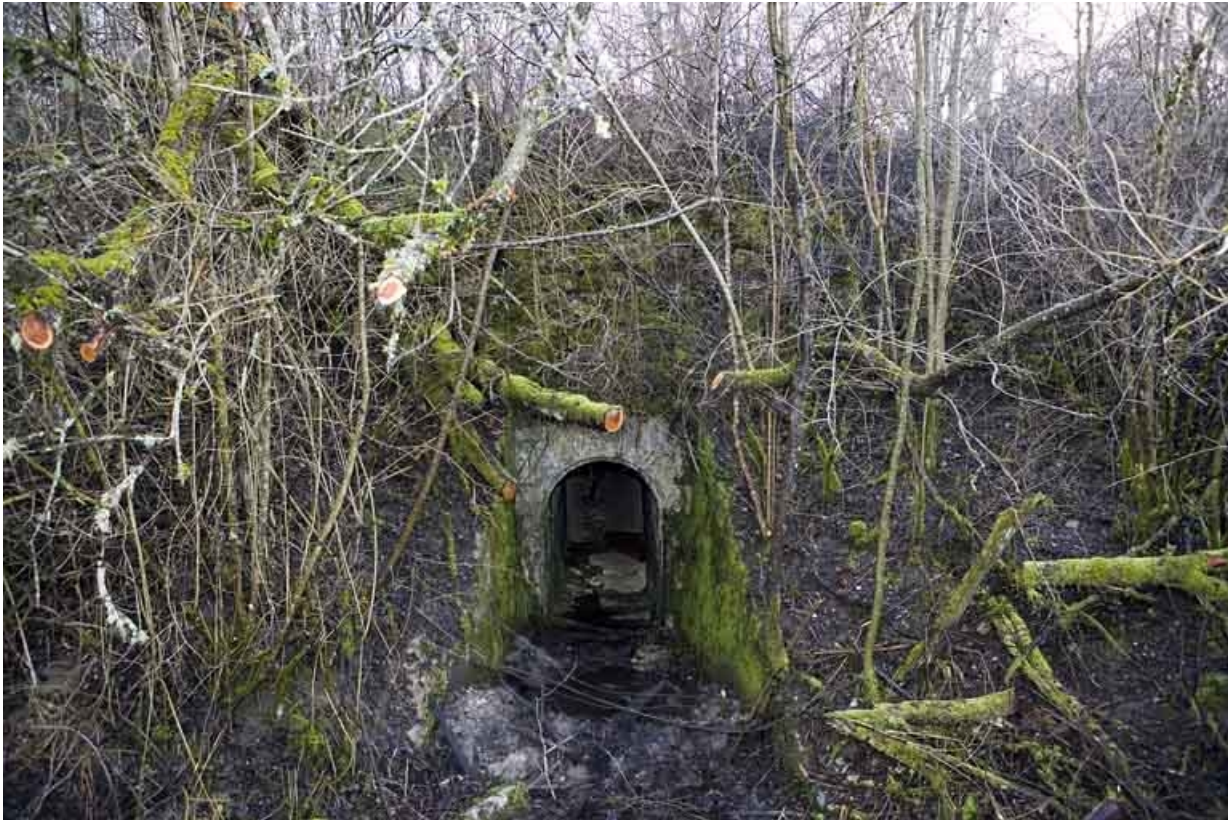
Réservoir, Pâturage de Montsevely : aqueduc d'évacuation.
