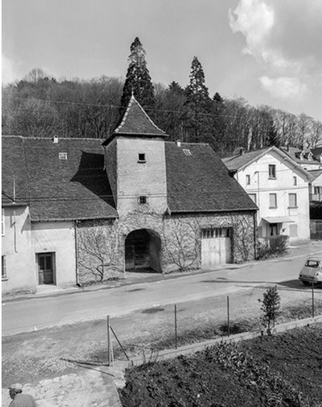
Façade antérieure, vue de face.
