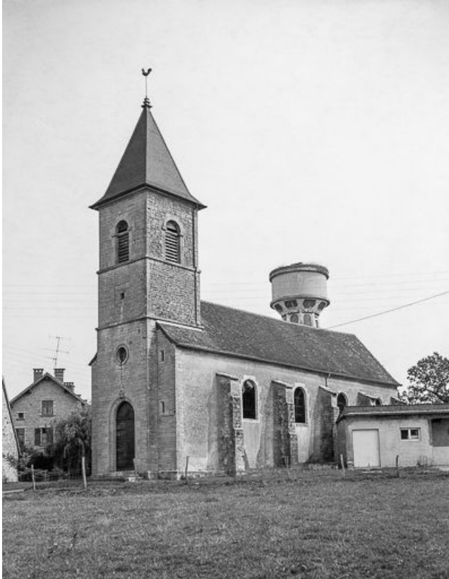
Façade antérieure et face droite.
