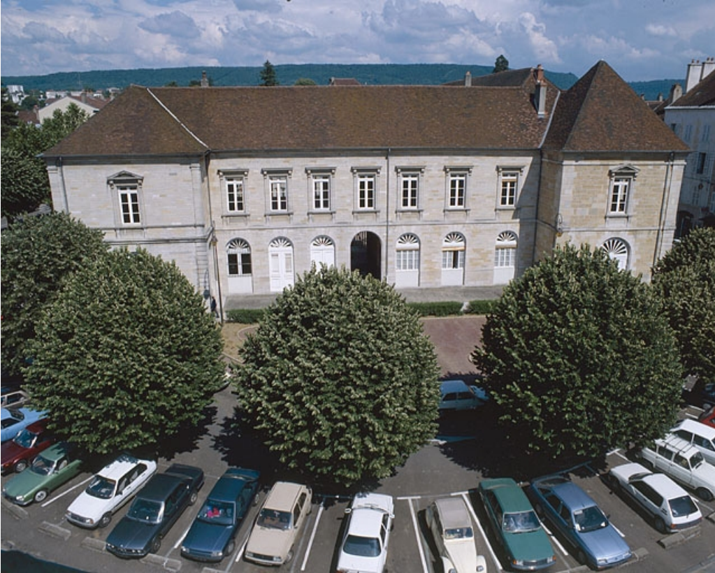
Façade ouest, vue d'ensemble.
