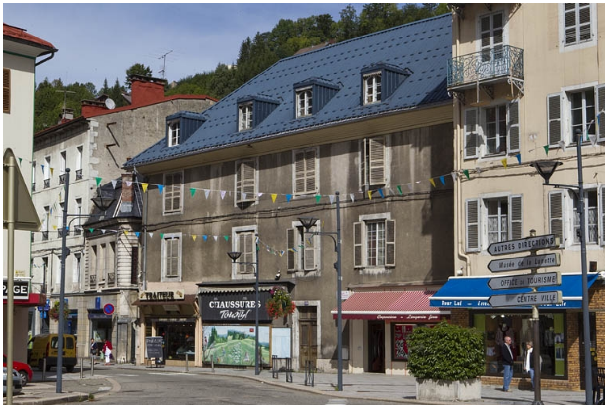
Elévation antérieure, de trois quarts droite.
