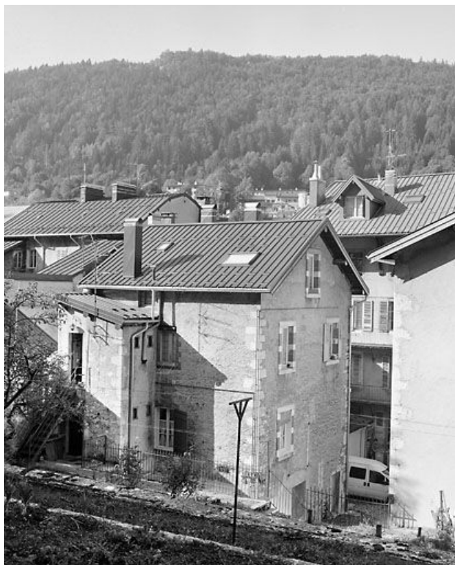
Bâtiment sud, vu du jardin.
