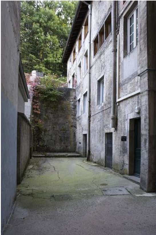
Cour, ancien atelier et mur de soutènement.
