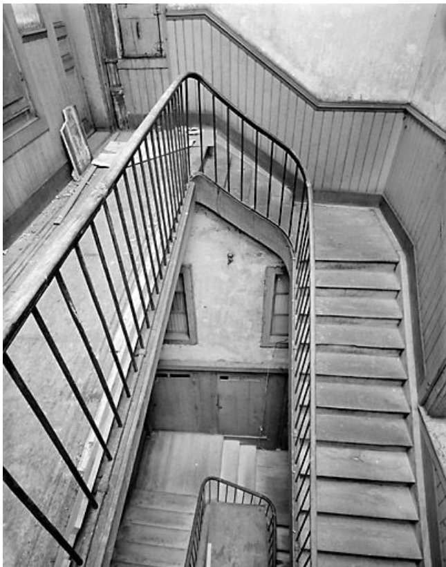
Vue plongeante sur la cage d'escalier.
