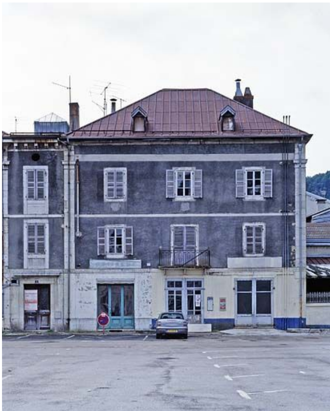
Le corps de bâtiment occidental.
