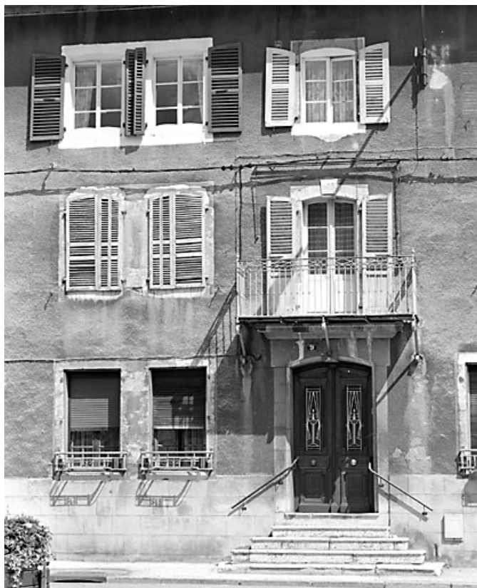
Façade antérieure : travées centrales.
